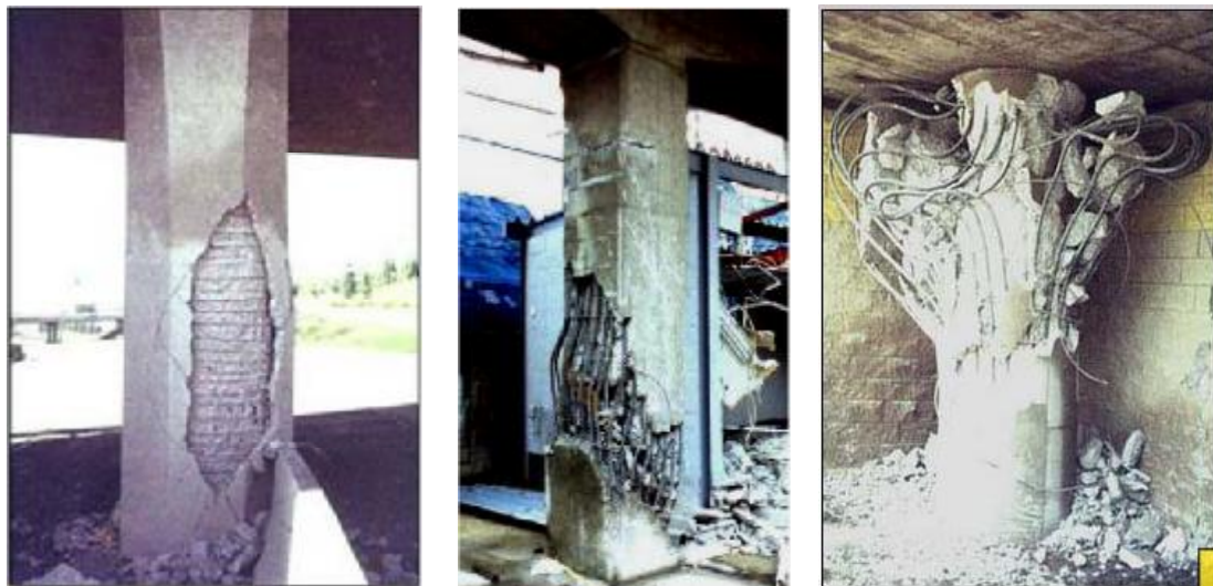
Slika 1. Primeri oštećenih stubova Figure 1. Examples of damaged columns
