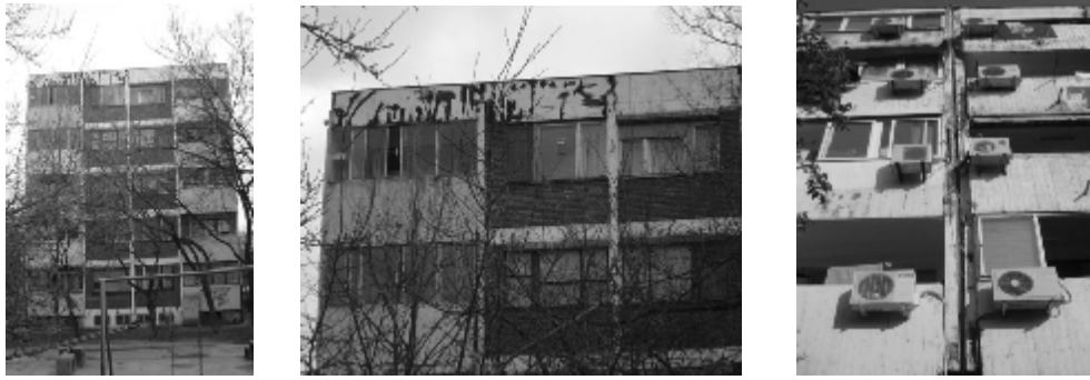
Slika 10. Fasade objekta AR 23-35 sa vidnim oštećenjima i spoljnim delovima klima jedinica Fig. 10. AP 23-35 block damaged façades and outdoor elements of HVAC units
