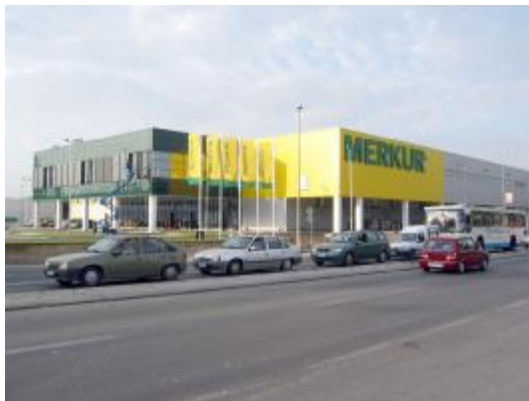
Slika 5. Poslovni objekat Merkur u Novom Sadu Fig. 5. Business object Merkur, Novi Sad
